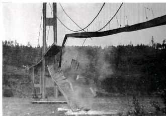
El desastre del puente de Tacoma.
