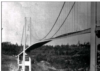
El desastre del puente de Tacoma.
